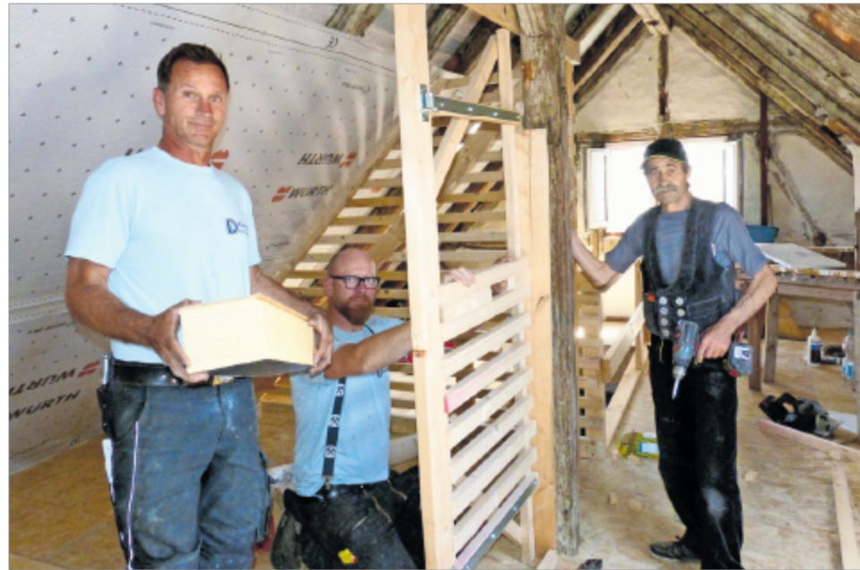
Rainer Daboci und seine Mitarbeiter Marcel Kirschke und Georg Kaltenhofer (von links) bauen den Dachboden fachgerecht aus. Foto: Müller
