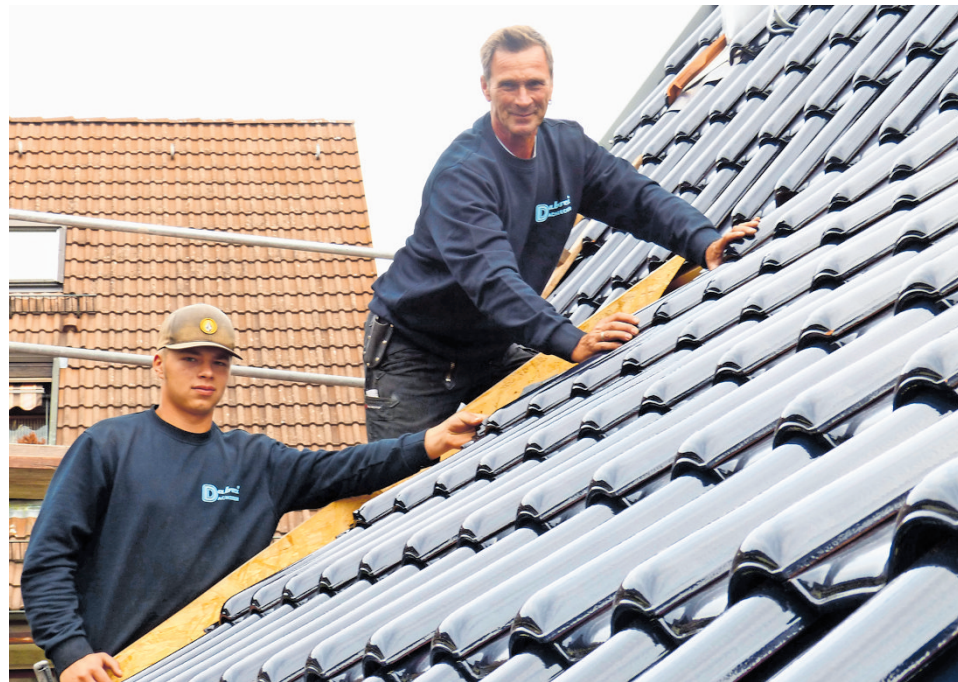
Wenn der Vater mit dem Sohne: Leon und Rainer Daboci (rechts) verlegen die Ziegel. Eben ein Dach aus Meisterhand. Foto: Müller
